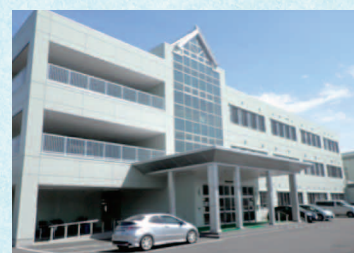
雄和中学校建設
