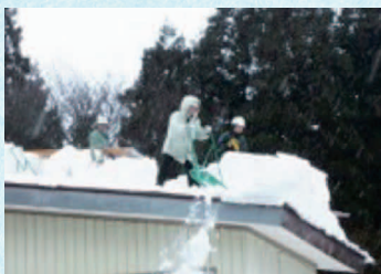
雪下ろし作業
