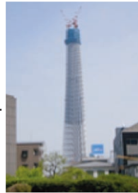
2010年 工事中の 東京スカイツリー
