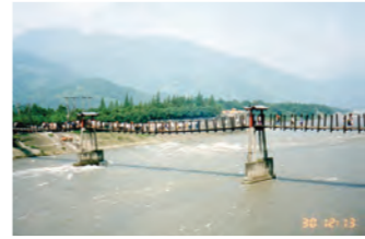
9. 引水灌漑施設
