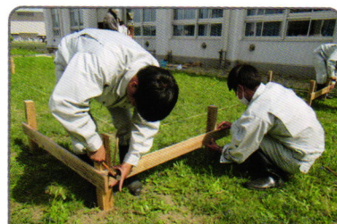
水盛り工地方
