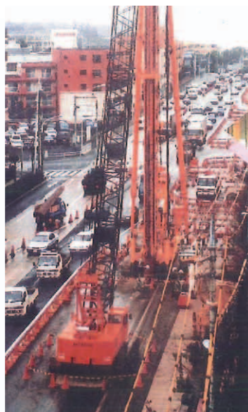
環八井荻立体トンネル
