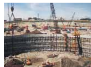
写真2.日本最大級地中タンク 内部掘削状況
