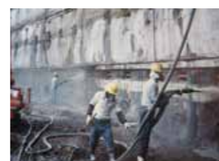
写真8.タンク内 コンクリート吹付作業 厚さ8cm
