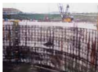
写真3.地中タンク内部掘削 土砂揚土状況150tクレーン使用
