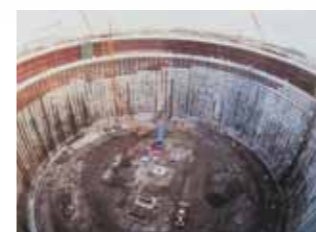
写真4.掘削直径103m深さ45m 日本最大級床付完了状況
