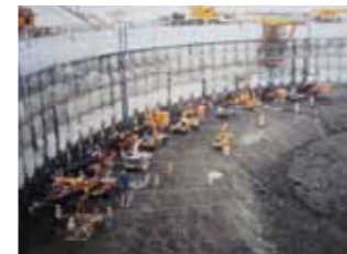
写真6.ロックアンカー削孔状況 削孔径13.5cm
